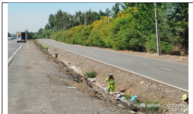
Trabajos de Limpieza de Fosos, Sub-Sector 2D
