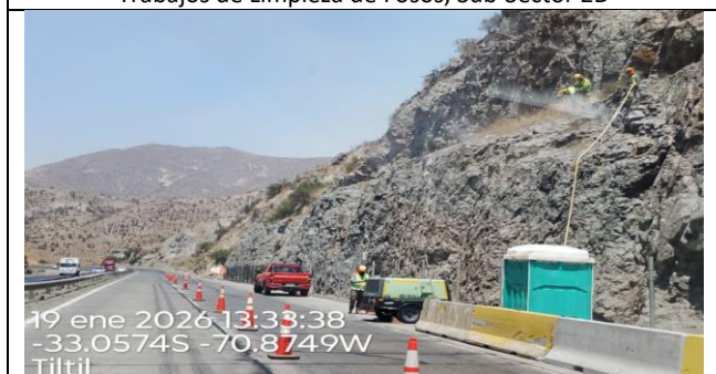
Trabajos de Mantenimiento de contención de Talud en Cuesta La Trampilla, Sub-Sector 2D
