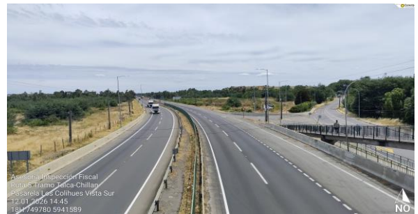
Dm 410,739 – Panorámica Vista Sur Pasarela Los Colihues.
