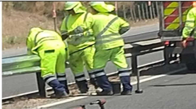
Reposición de Barreras Km. 96+440- Mediana
