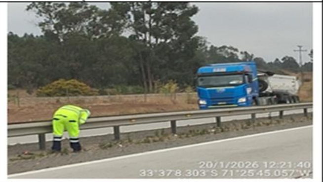
Limpieza de reflectantes Km. 89+400- Mediana
