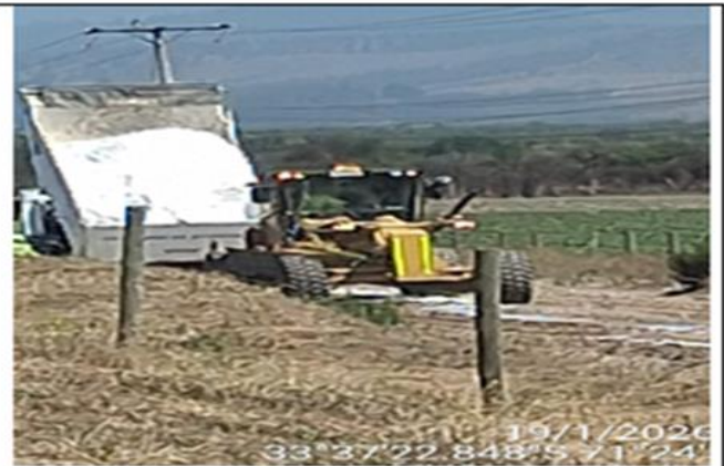
Mantenimiento de Calle de Servicio Derecha (Bischofita)- Km. 87+000
