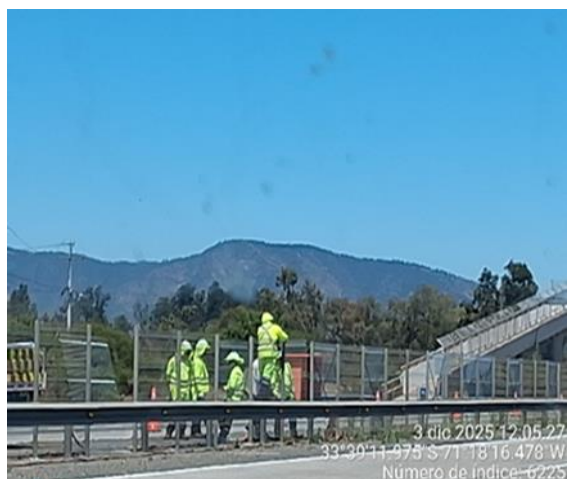
Reposición de Vallas km. 76+640 Descendente
