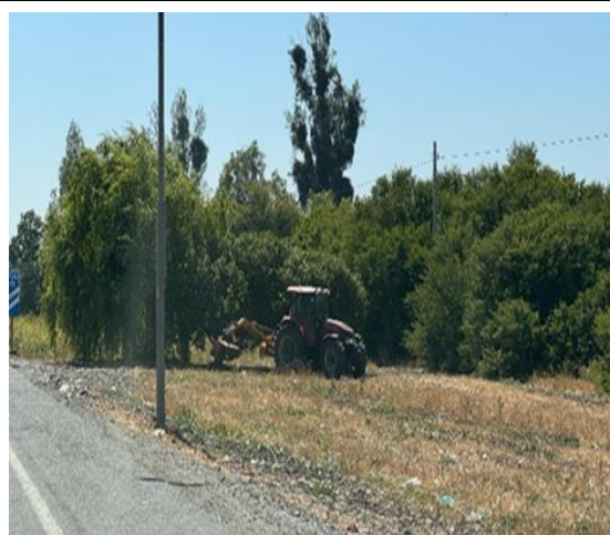
Mantencción y Limpieza en Faja Fiscal Km. 62+400- Descendente
