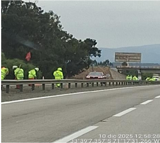
Mantenimiento de Faja km. 75+400 Mediana
