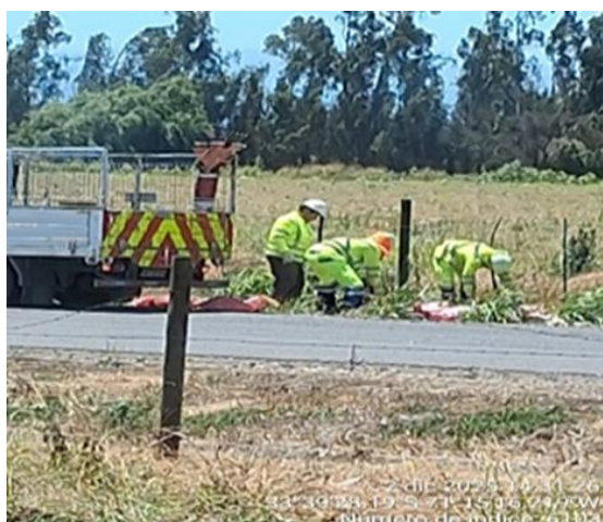
Retiro de Basuras km.71+700- Ascendente
