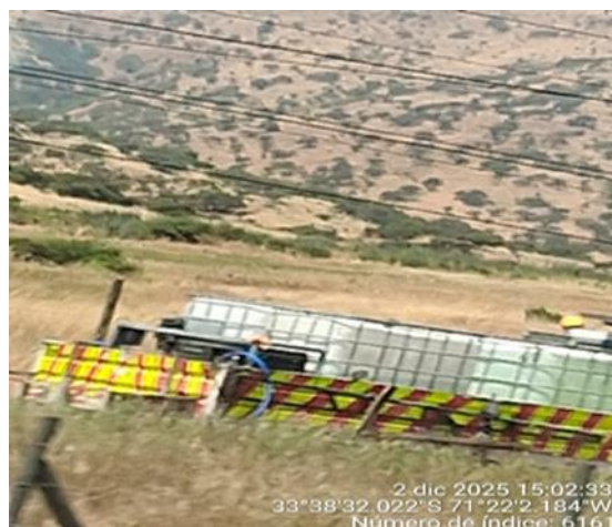
Aplicación de Matamalezas Km. 99+100- Ascendente
