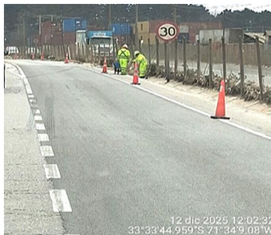
Limpieza de cunetas Km. 0+600- NAPSA Descendente
