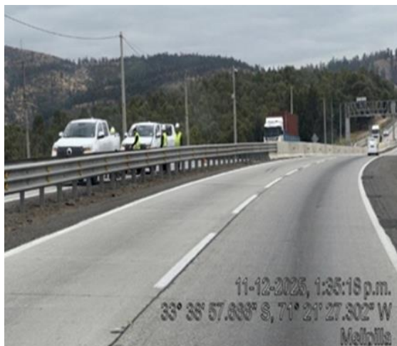
Sello de Grietas Km. 81+800 Descendente
