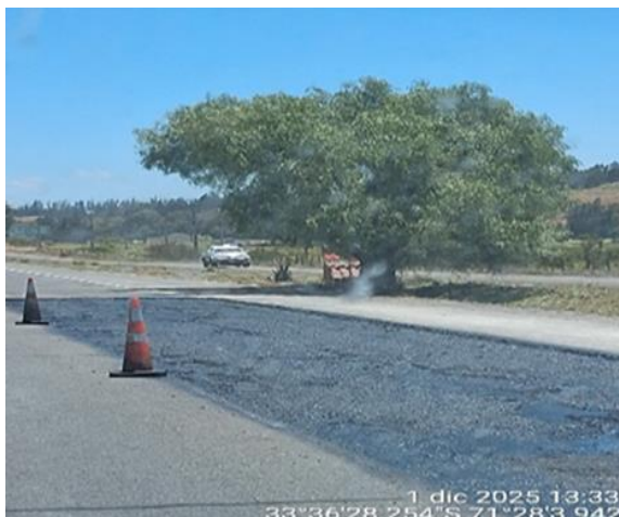
Mantencción de Pavimento P3 Km. 93+300- Ascendente
