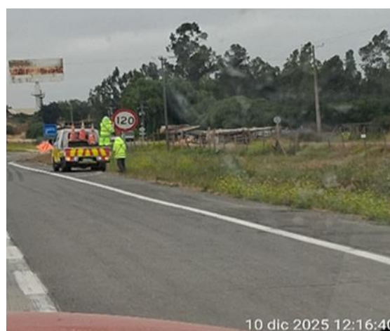
Limpieza de señal vertical Km. 74+100- Ascendente
