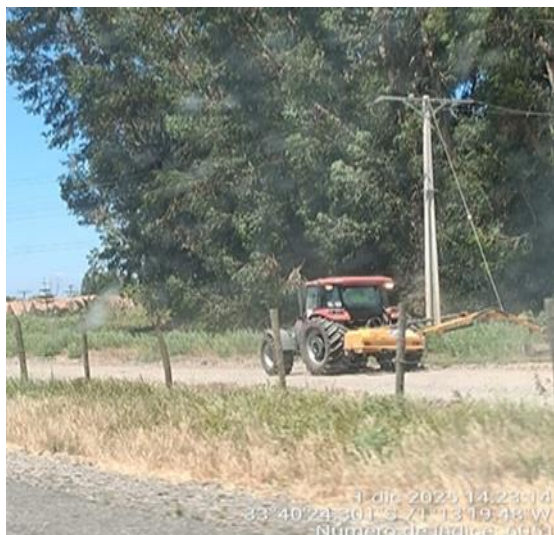
Roce mecanizado Km. 68+633- Calle de Servicio Sur
