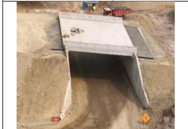
Construcción Paso Superior Enlace San Juan Dm 129.740
