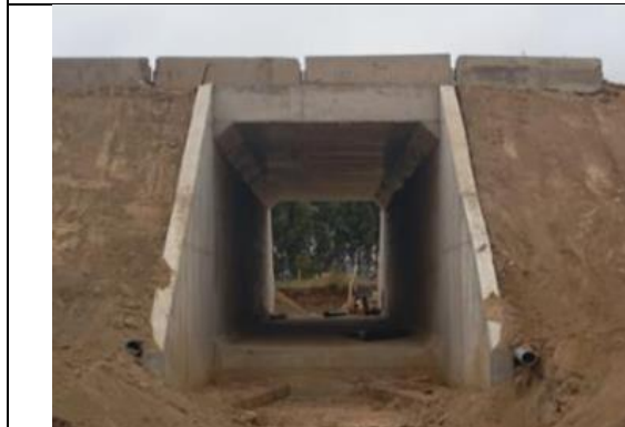
Construcción Paso Superior Interpredial N°132 Dm 132.255
