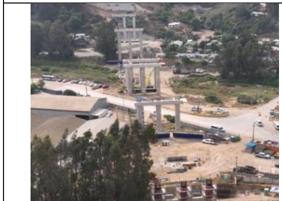
Construcción Viaducto San Juan Dm 130.599 - 130.959
