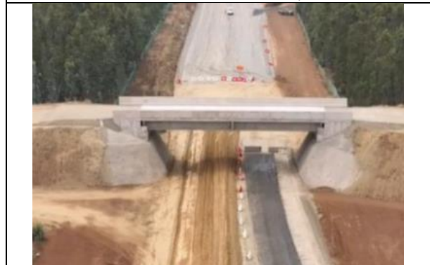
Construcción Paso Inferior Los Lilenes, Dm 123.720
