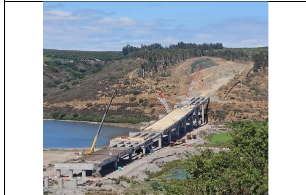
Construcción Viaducto Maipo, Dm 125.309
