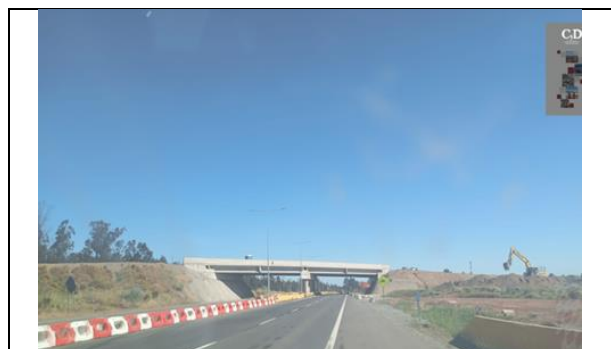
Construcción Paso Inferior Las Brisas, Dm 123.256
