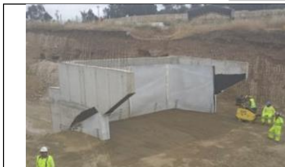
Construcción Paso Inferior Conexión Ruta G-908 Dm 130.408
