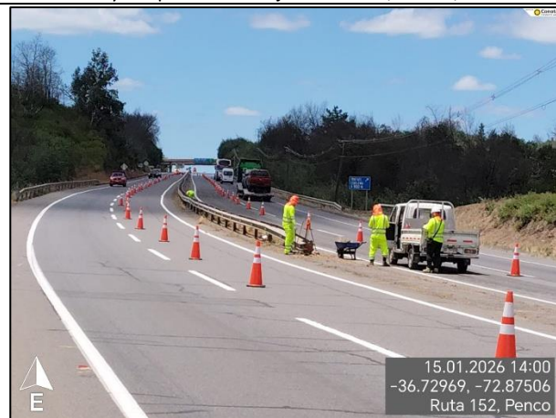
Limpieza de mediana. Ruta 152, Km 61,340.
