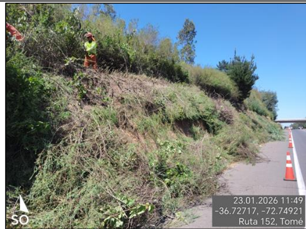
Roce y Limpieza de la Faja. Ruta 152, Km 49,300.
