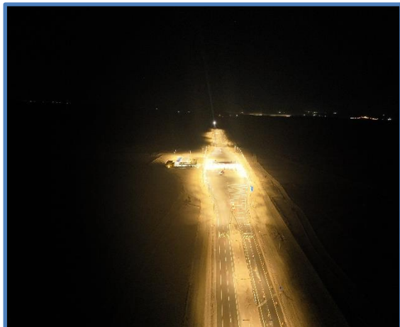
Plaza de Peaje Cerritos Bayos Vista Norte
