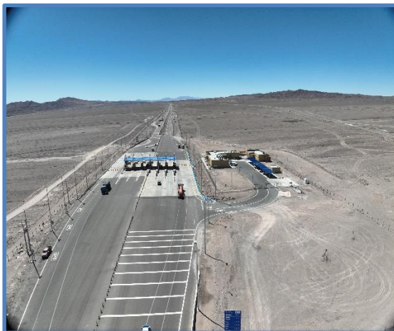
Plaza de Peaje Cerritos Bayos Vista Sur
