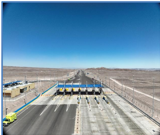
Plaza de Peaje Cerritos Bayos Vista Norte
