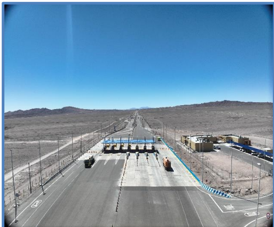
Plaza de Peaje Cerritos Bayos Vista Sur
