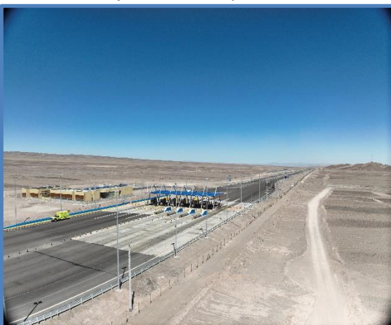
Plaza de Peaje Cerritos Bayos Vista Norte
