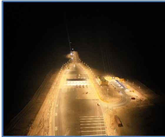
Plaza de Peaje Cerritos Bayos Vista Sur
