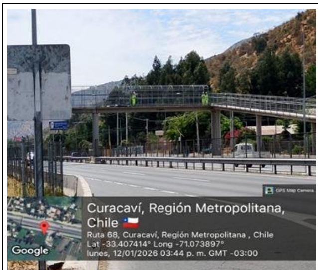
Trabajos Mantención de pasarela
