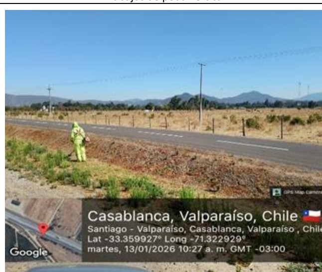
Trabajos de limpieza roce
