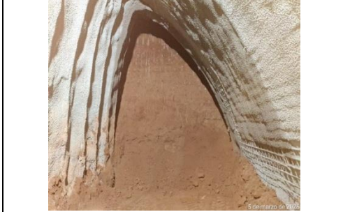
Excavación Fase III
