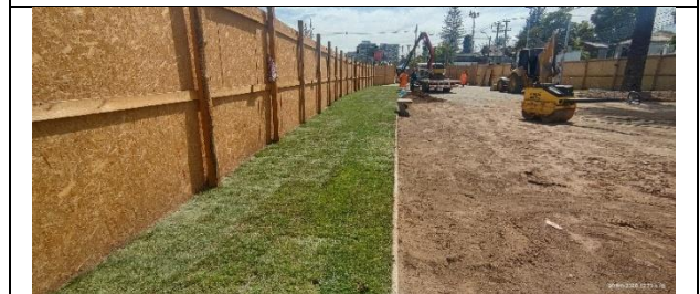
Obras reposicion plaza sector Los Corteses
