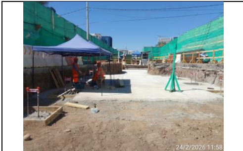
Excavación y descabezado de pilas sección "C"
