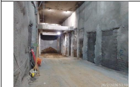
Muros forro en trinchera bajo estampidores.
