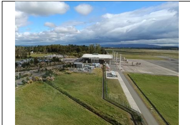
Vista del aeropuerto desde la Torre de Control
