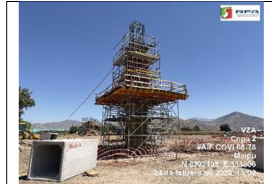
V.Z.A. cepa 2. Enfierradura de elevación y hormigonada.
