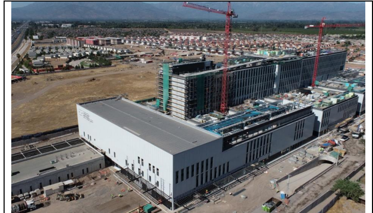
4.- Fachada Nor Oriente
