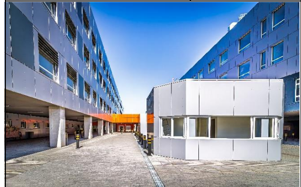
Fachada ING y HDS
