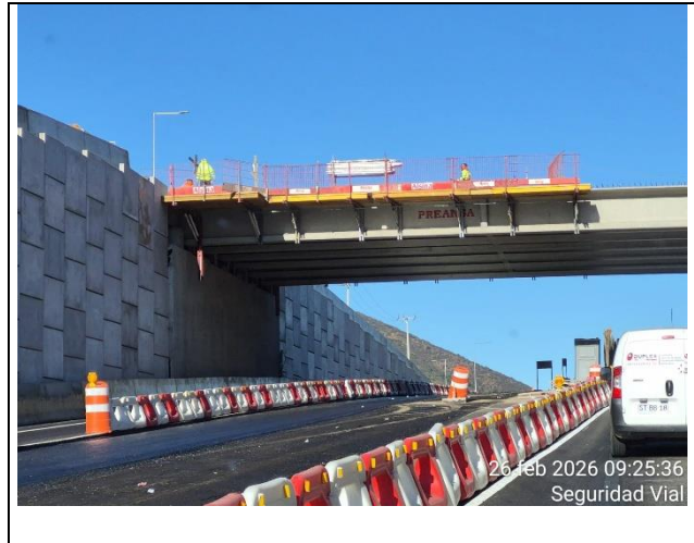
Sector 1. Sector Cumbres Dm. 10.900 app. Trabajos en Tablero Superestructura.
