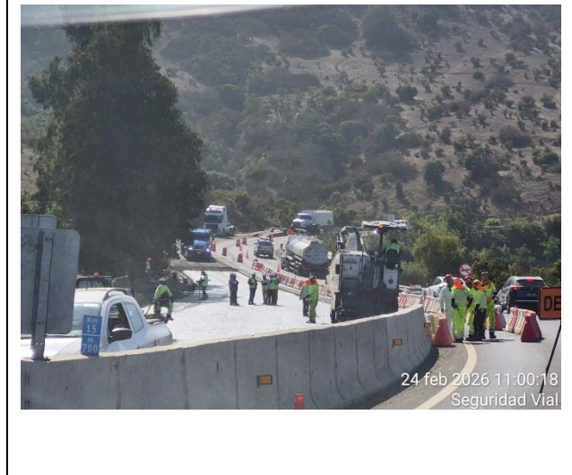
Sector 1 Sector Cuesta Dm 15.000 Trabajos de fresado
