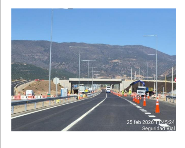
Sector 1 km 3.2 a 6 app. F-20 Trabajos de Pavimentación Doble Calzada y elementos de Seguridad Vial
