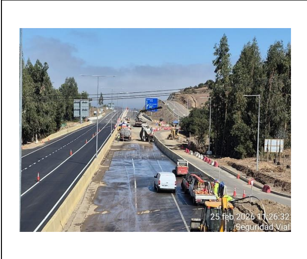
Sector 1 Pasarela N°4 Dm 16.500 Pavimentos y Obras de Arte
