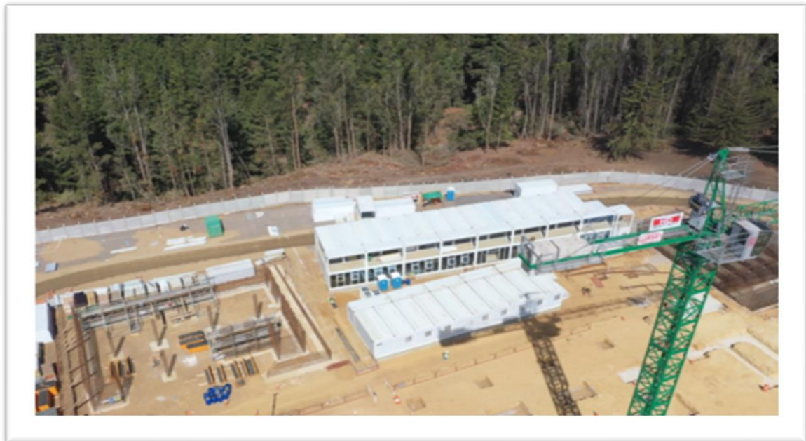
Vista General Armaduras Sala Cuna e Instalación de Faenas- Vista 2
