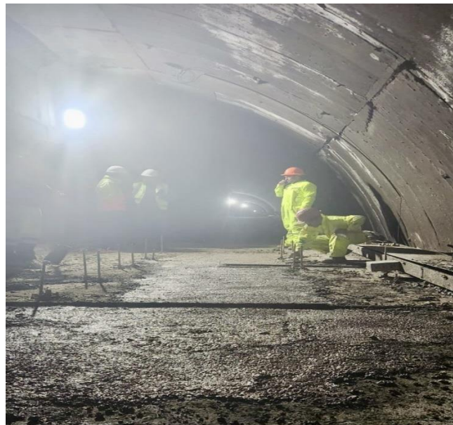
Trabajos de reparación Tunnel Lo Prado
