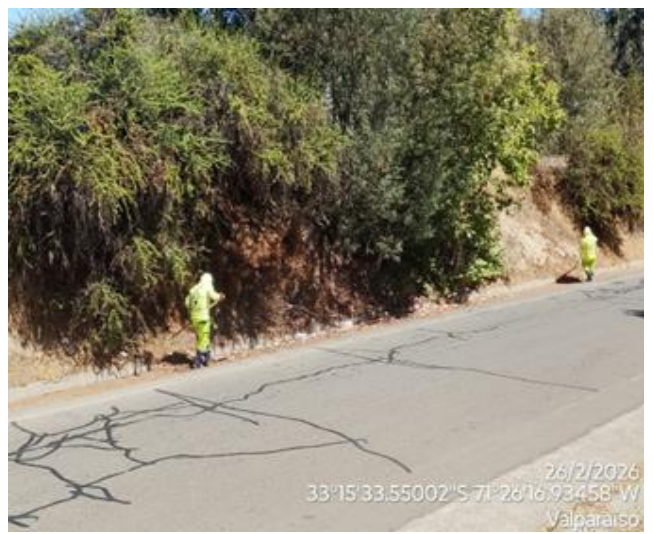
Mantenimiento de cunetas revestidas.
