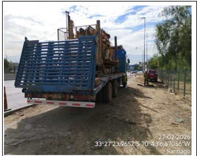
Trabajos de Sondaje
