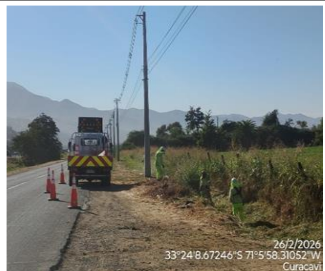
Mantenimiento de fosos y contra fosos en tierra.
