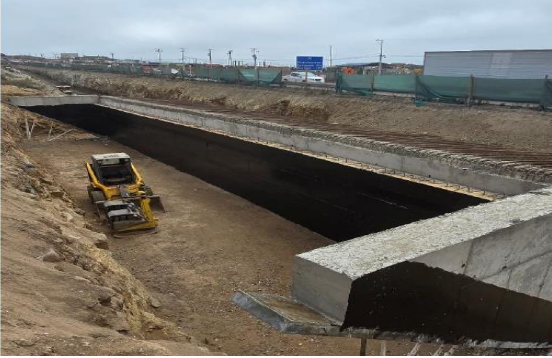
Trabajos Paso Inferior Avenida Panorámica
