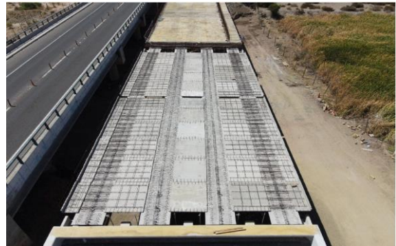
Trabajos Puente Quebrada Seca
