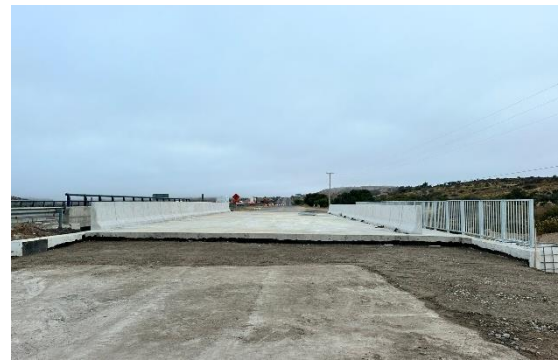
Puente El Almendro
