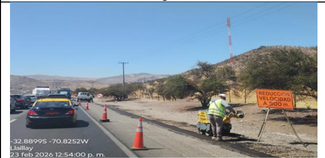
Trabajos de Mantenimiento y conservación de bermas Sub-Sector 2D
