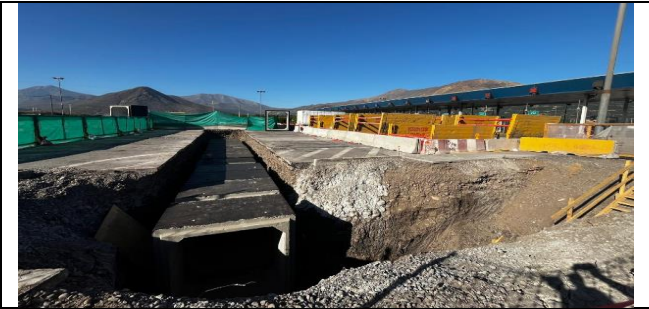
Instalación de cajones prefabricados: Pasillo técnico PP Las Vegas
