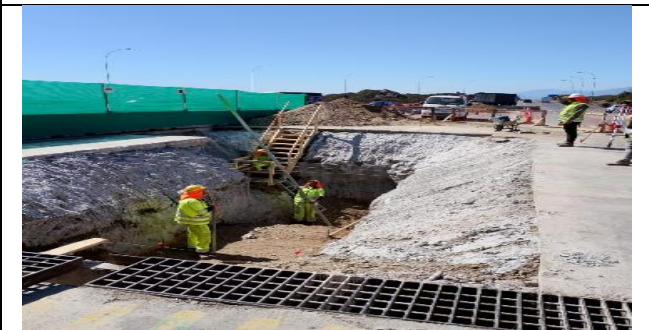
Trabajos excavación para pasillo técnico PP Pichidangui
