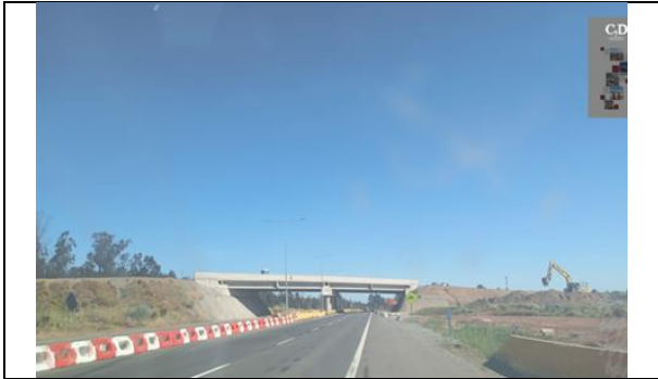
Construcción Paso Inferior Las Brisas, Dm 123.256
