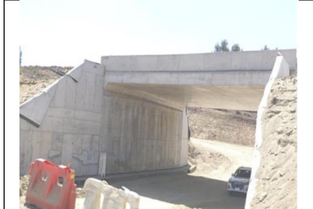
Construcción Paso Superior Interpredial Reuss (dm 133.733) n°133 (ex 21)
