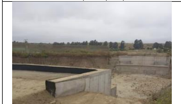
Construcción Paso Superior Los Alerces (dm 132.679)
