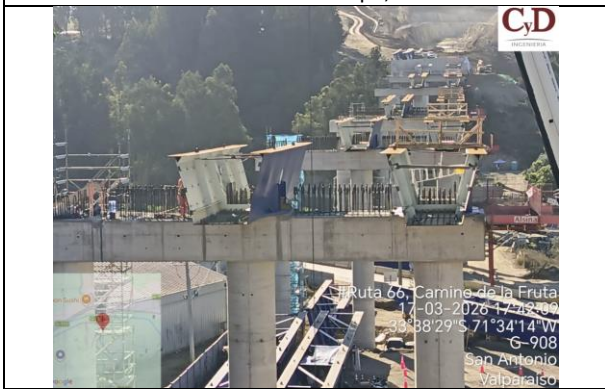
Construcción Viaducto San Juan Dm 130.599 - 130.959
