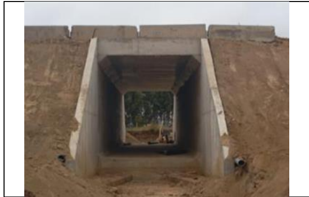
Construcción Paso Superior Interpredial N°132 Dm 132.255
