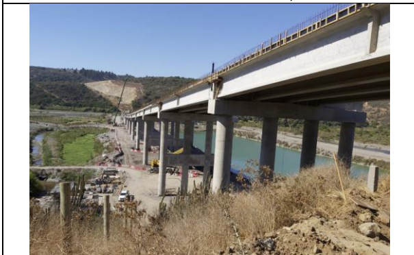
Construcción Viaducto Maipo, Dm 125.309
