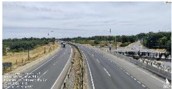
Dm 410,739 – Panorámica Vista Sur Pasarela Los Colihues.
