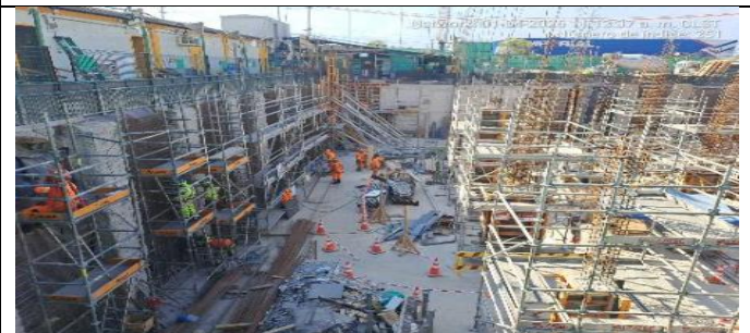
Edificio de Control
