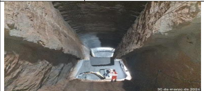
Excavación Fase VII TEO.
