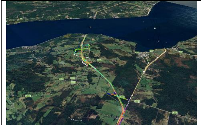
Sector A, Acceso Sur Puente Chacao – Empalme Ruta 5 (Chacao)
