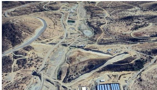
Fotografía N°3, Vista de las obras y campamento
