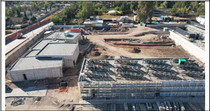
5.- Edificios REAS e Instalaciones
