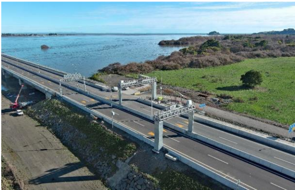
Sector A – Pórticos telepeaje – Hualpén
