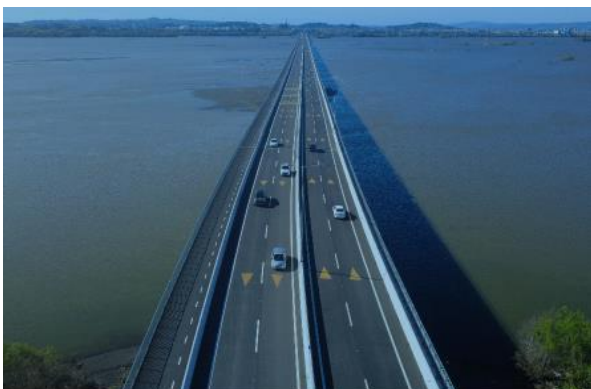
Sector B –Desde estribo Entrada norte – Hualpén
