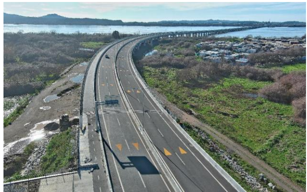
Sector C – Estribo Salida lado sur – San Pedro de la Paz
