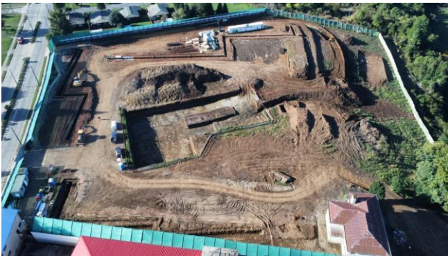
Obras Preliminares Hospital La Unión
