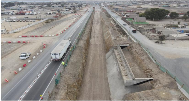
Trabajos Paso Inferior Avenida Panorámica
