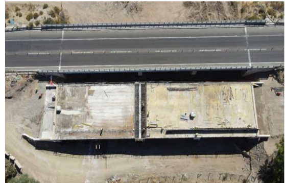
Trabajos Puente Quebrada Seca
