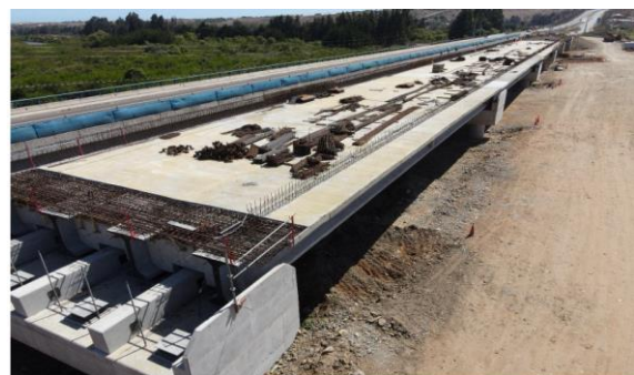
Trabajos Puente Huentelauquén
