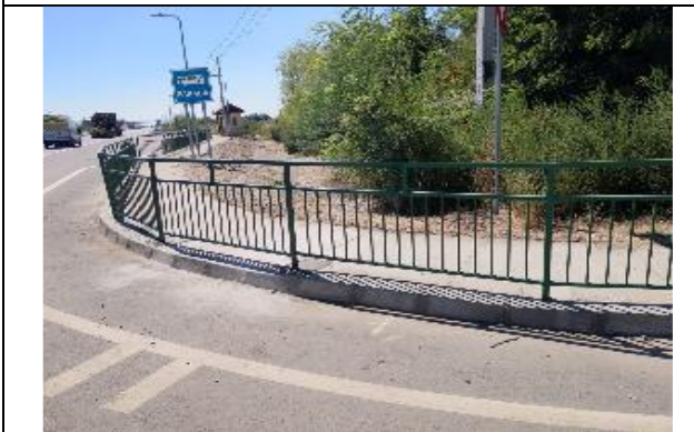
Reparación y conservación Valla Peatonal
