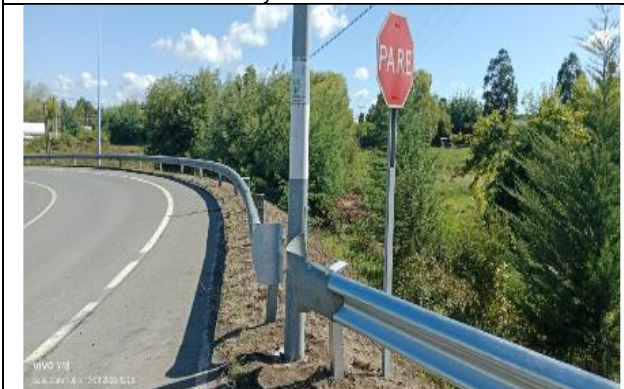
Reparación y Conservación de Barreras de Contención Metálicas
