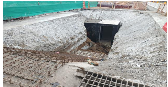
Trabajos en pasillo técnico Plaza de Peaje Pichidanguí ( Sub-Sector F )
