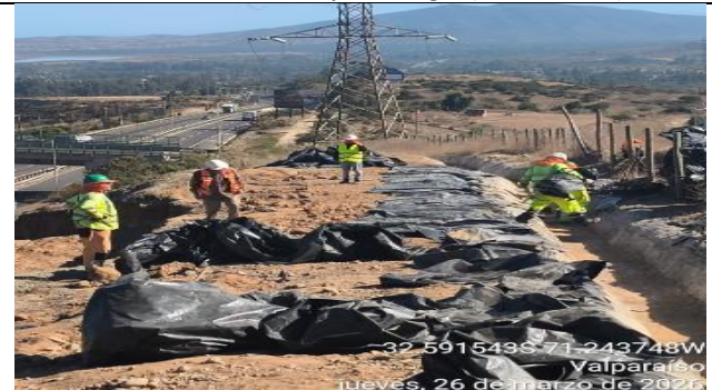
Trabajos preliminares de remoción de material en taludes El Melón ( Sector 1 )
