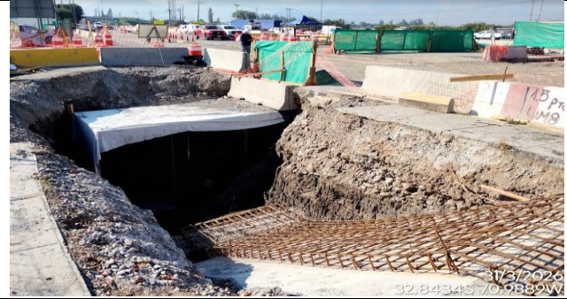
Relleno de pasillo técnico y trabajos de enfierradura para escalera, Plaza de Peaje Las Vegas ( Sub-Sector E )
