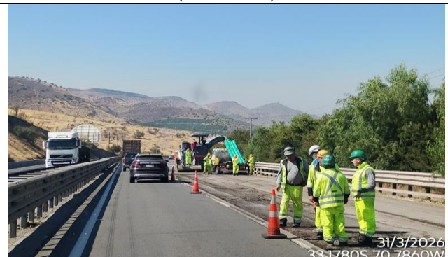
Trabajos de recapado asfáltico (Cuesta El Manzano Sub-Sector D)
