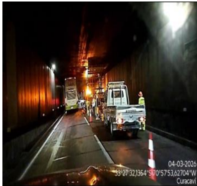
Trabajos de Mantencion Boveda Tunnel Lo Prado
