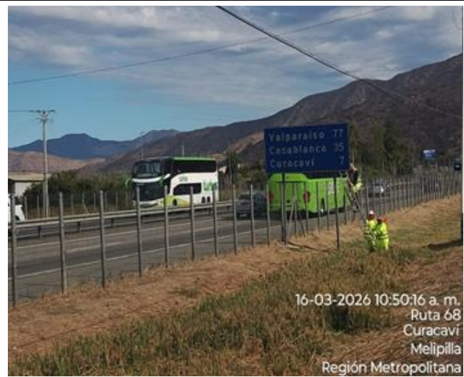
Trabajos de Limpieza señales Camineras
