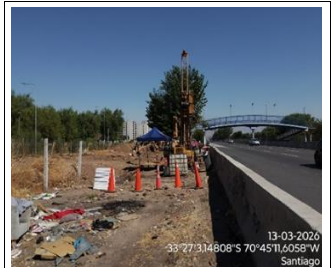
Trabajos de Sondaje
