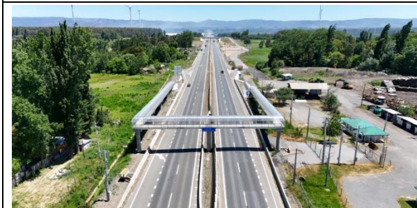
Ilustración N°5: Pasarela Chequen Dm 20.610
