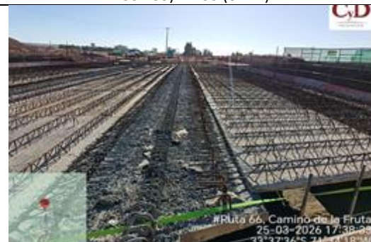
Construcción Paso Superior Los Alerces (dm 132.679)
