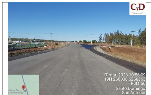
Construcción Paso Inferior Las Brisas, Dm 123.256
