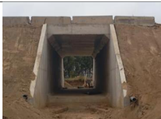
Construcción Paso Superior Interpredial N°132 Dm 132.255
