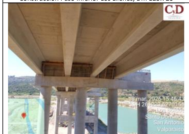
Construcción Viaducto Maipo, Dm 125.309
