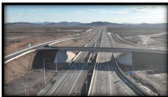
Estructura P.I. Calle Nueva 3
