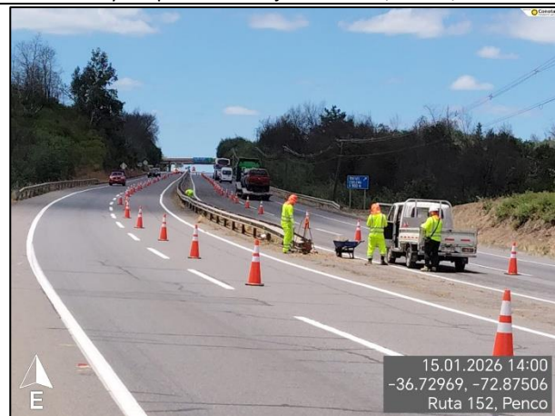
Limpieza de mediana. Ruta 152, Km 61,340.
