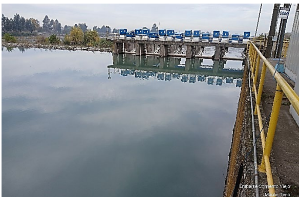
Imagen N°2. Vista de la poza y zona de captación con 10 m3/s hacia el canal Teno Chimbarongo y compuertas con 4 m3/s hacia el río Teno.
