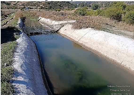
Imagen N°7. Canal Panamá, km. 4+160. Vista aguas arriba del canal revestido y rejilla de protección.
