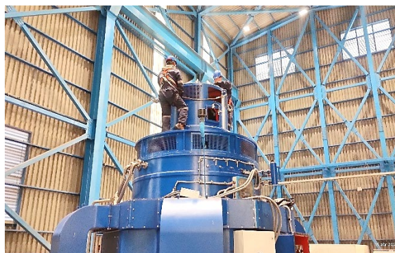
Imagen N°4. Proceso de mantenimiento del generador de la unidad 2 de la Central Hidroeléctrica.
