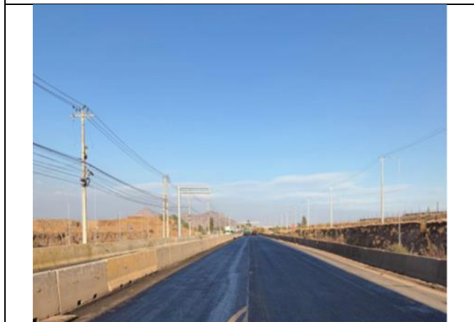
Asfaltado Calzada poniente Tramo B2
