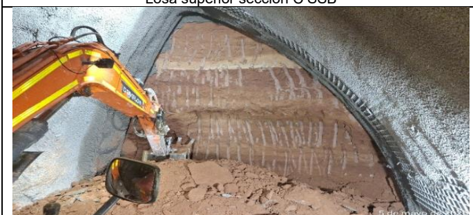
Excavación Fase III TEO
