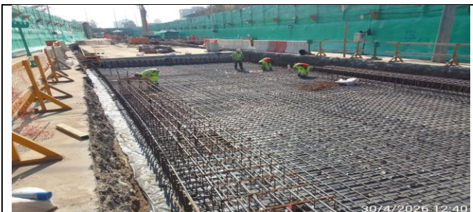
Losa superior sección C SSB
