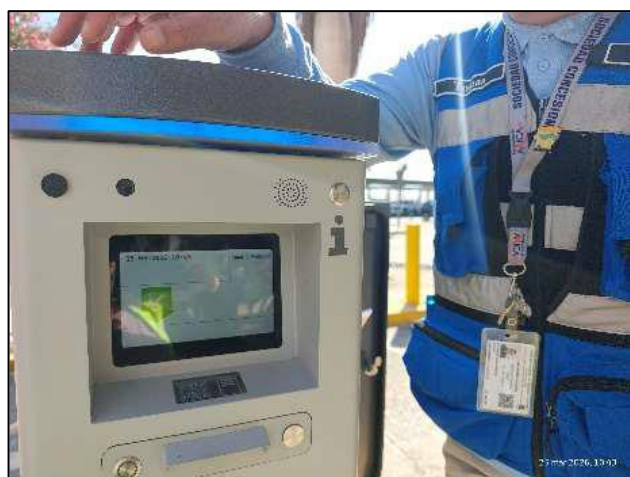
SC ejecuta limpieza de equipos de Parking.
