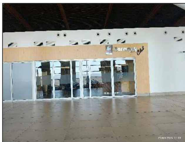
Se reinician los trabajos en el Salón VIP.
