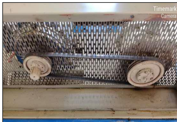
SC ejecuta cambio de corre de transmision de soplador
