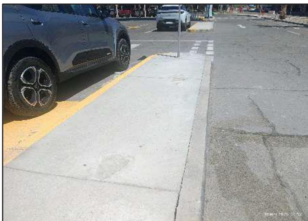
SC ejecuta reparación de acera sector estacionamiento.
