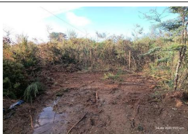
Apertura de camino, Puente Mechaico
