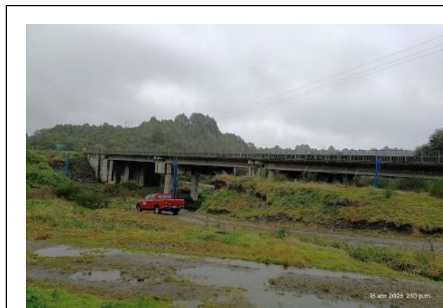
Sondaje – Puente Butalcura
