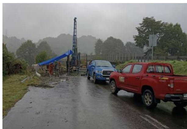
Sondaje – Puente Puntra
