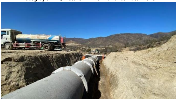
Fotografía N°2, Rellenos estructurales OA N° 21. Variante Ruta E315
