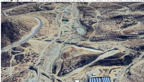
Fotografía N°3, Vista de las obras y campamento
