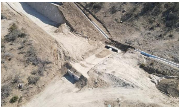
Fotografía N°1, Vista OA N°15. Variante Ruta E-315
