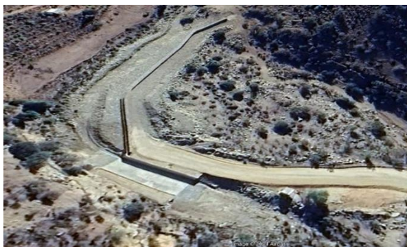
Fotografía N°5, Vista estación de control fluviométrica Frutillar
