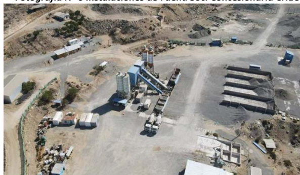
Fotografía N°7. Planta de hormigón
