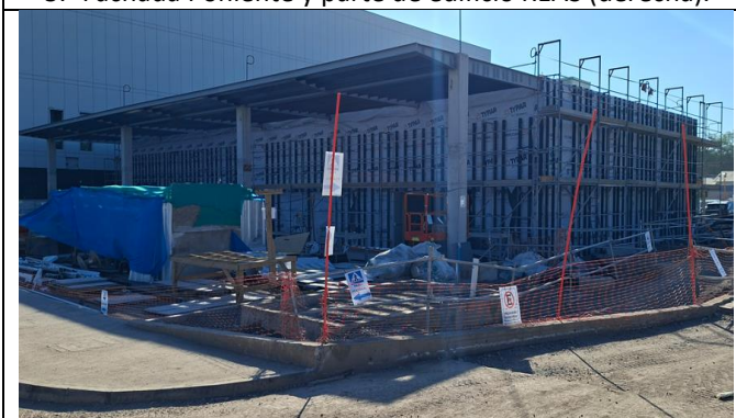
6.- Fachadas Oriente y Sur Edificio SAMU
