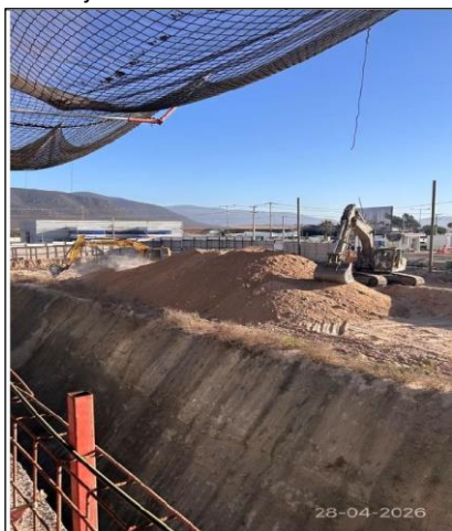
Trabajos de excavaciones en auditorio
