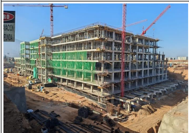
Vista Fachada Nor-Poniente (Sectores A-B)
