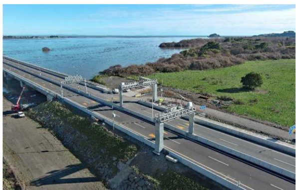
Sector A – Pórticos telepeaje – Hualpén
