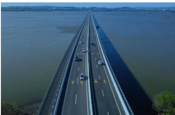
Sector B –Desde estribo Entrada norte – Hualpén
