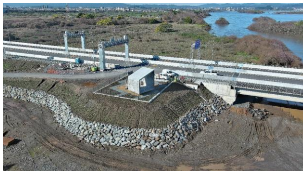
Sector A – Mirador – Hualpén
