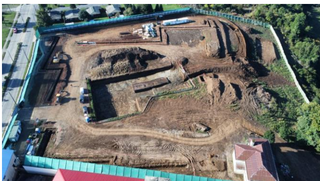
Obras Preliminares Hospital La Unión
