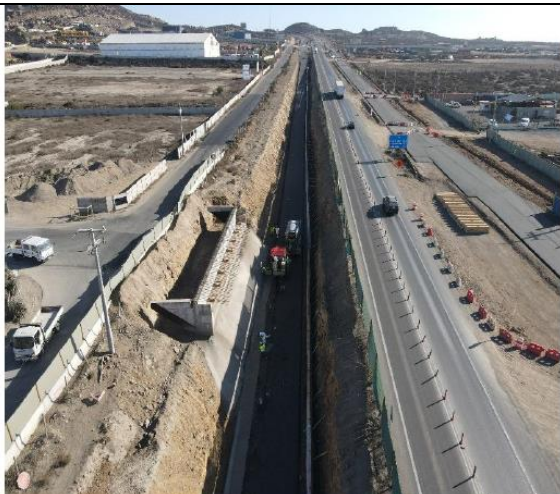
Paso Inferior Avenida Panorámica
