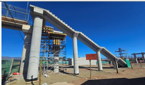
Pasarela Illapel Norte
