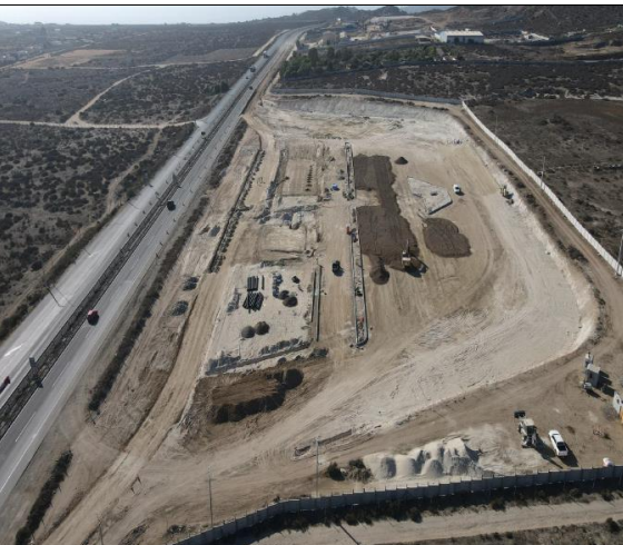
Área Servicios Generales ASG –08 – Km. 455.000.
