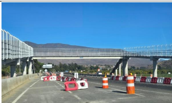
Pasarela Mincha Sur
