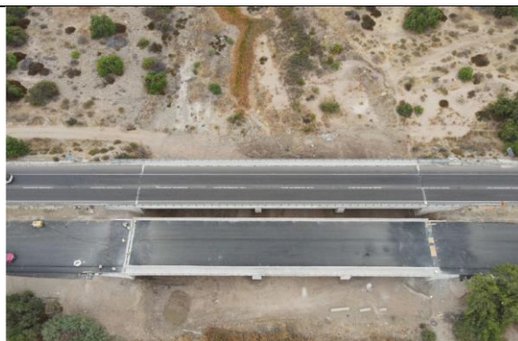
Trabajos Puente Quebrada Seca
