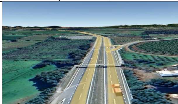
Pasarela Chumulco Existente
