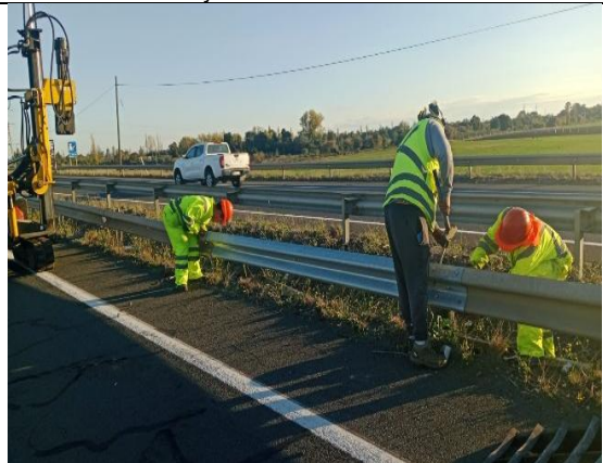
Reparación y Conservación de Barreras de Contención Metálicas
