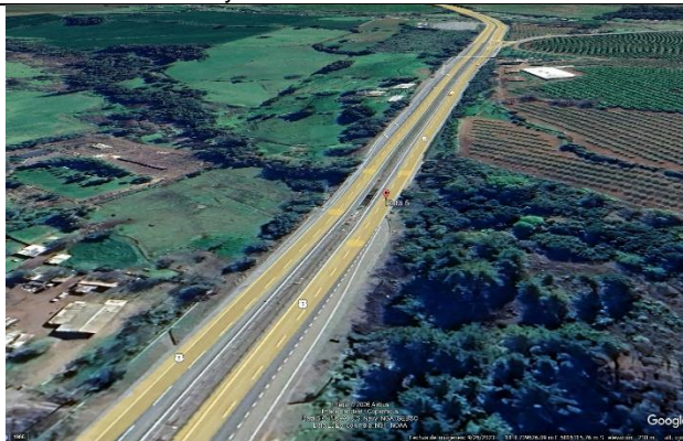
Puente Chumulco Existente
