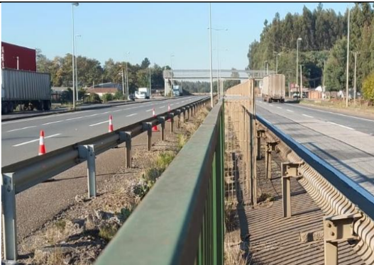
Reparación y conservación Valla Peatonal
