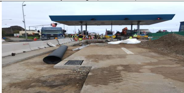
Avance de sistema de saneamiento y pasillo técnico Plaza de Peaje Pichidangui ( Sub-Sector F )
