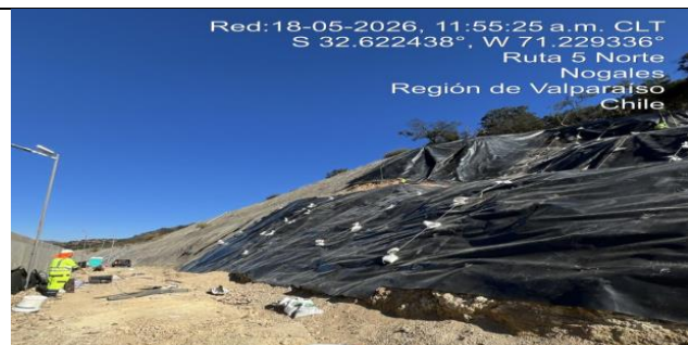
Trabajos de adecuación de proyecto provisorio en taludes El Melón ( Sector 1 )
