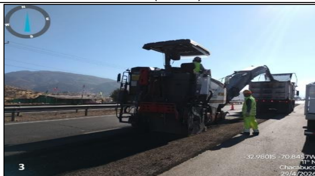
Trabajos de recapado asfáltico ( Sub-Sector D )
