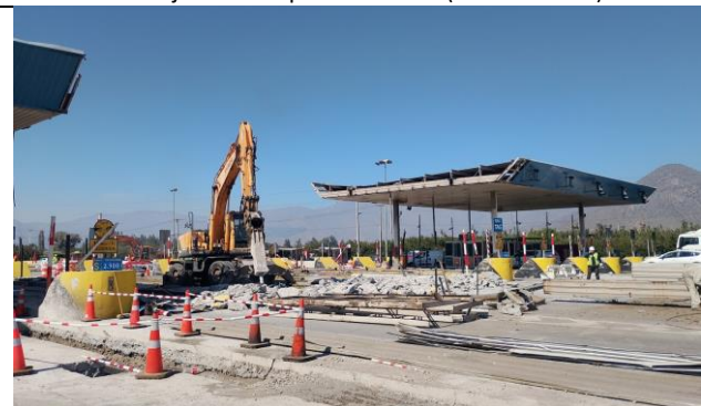
Ampliación de marquesina y casetas en zona central de Plaza de Peaje Las Vegas ( Sub-Sector E )
