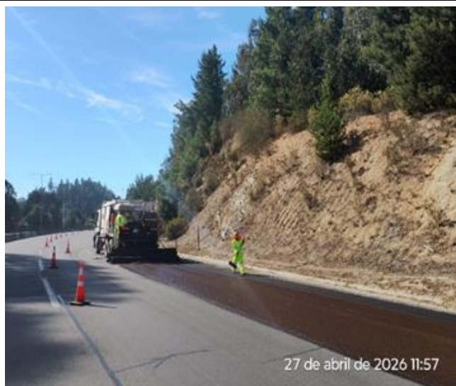
Trabajos Microaglomerado en frío [m2] KM 99.3 – 100.6
