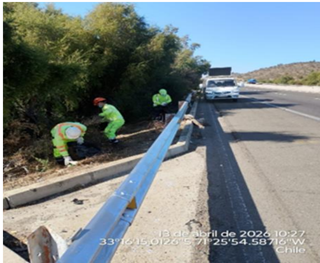
Trabajos de Limpieza de Faja KM 0 – 10.0
