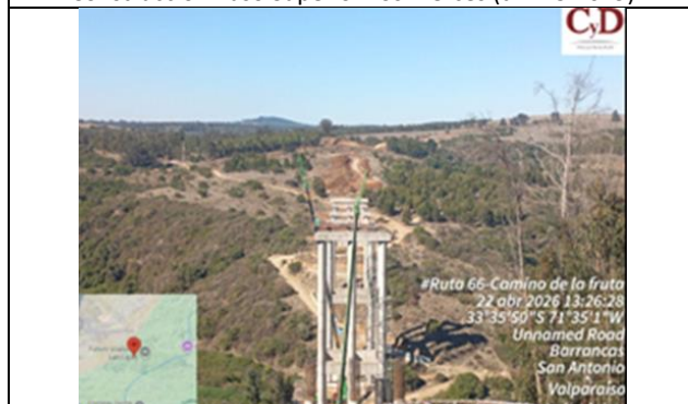
Construcción Viaducto Las Lajas (dm 136.200 - 136.652)
