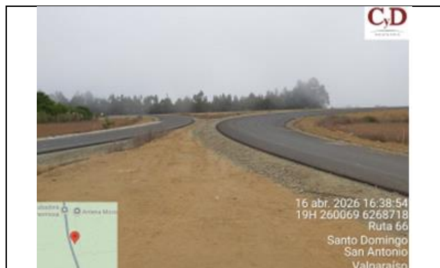
Construcción Paso Inferior Las Brisas, Dm 123.256
