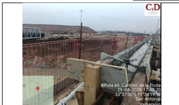
Construcción Paso Superior Los Alerces (dm 132.679)
