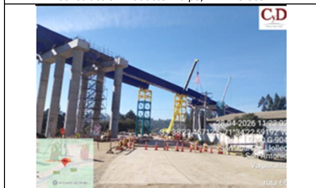
Construcción Viaducto San Juan Dm 130.599 - 130.959
