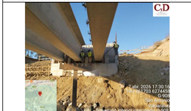
Construcción paso inferior conexión ruta G-908 (dm 130.408)
